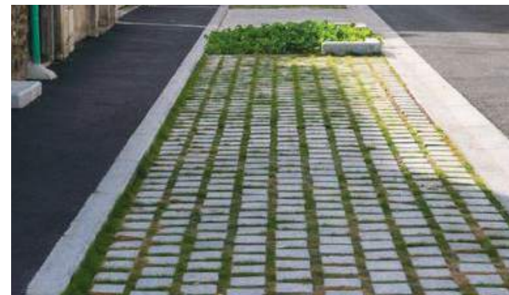
Stationnement avec pavé à joints végétalisés
