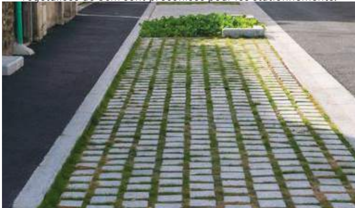
Stationnement avec pavé à joints végétalisés
