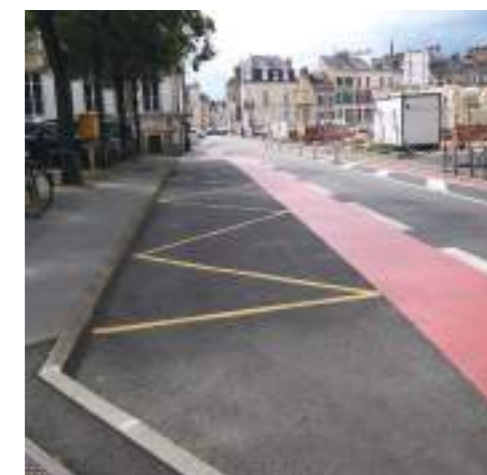
Place des Ifs - Elargissement du Blockhaus
